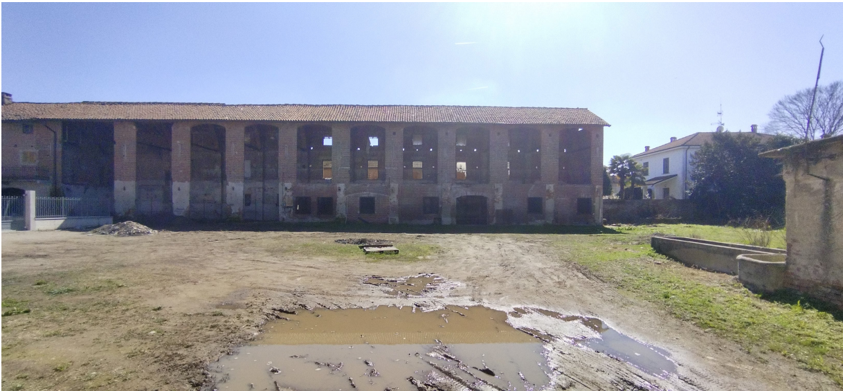
Fabbricato sud e area prativa nell'angolo sud ovest. Scatto da nord.
