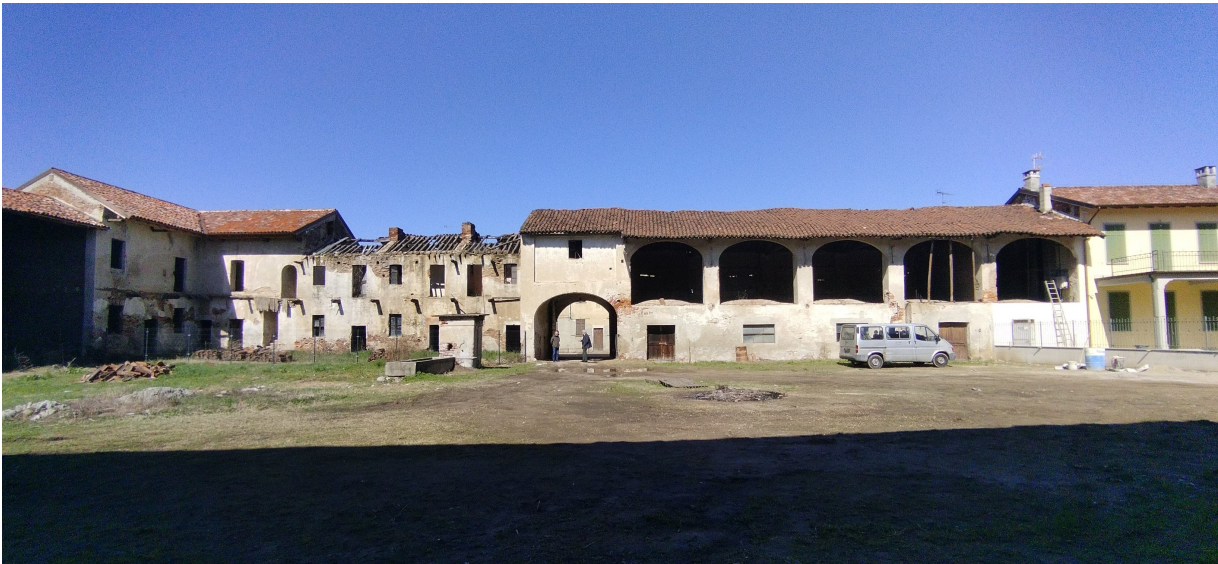
Fabbricati a nord con androne di ingresso. Scatto da sud.
